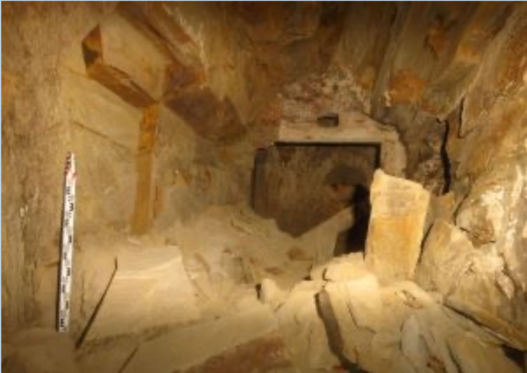
neues aus Nordbayern - Sanierung von 35 Felsenkellern in der Kellergasse Wunsiedel
