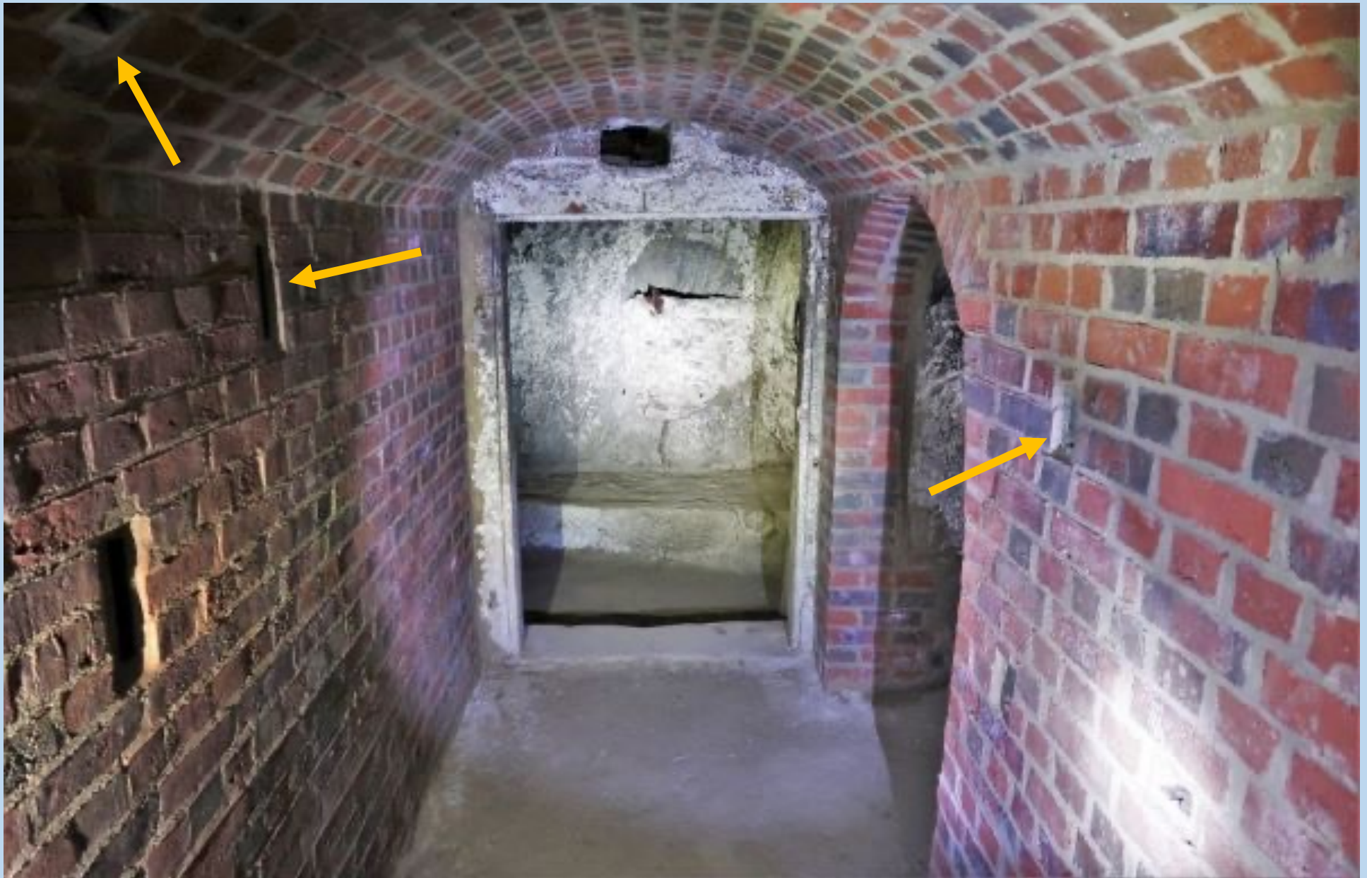
neues aus Nordbayern - Sanierung von 35 Felsenkellern in der Kellergasse Wunsiedel
