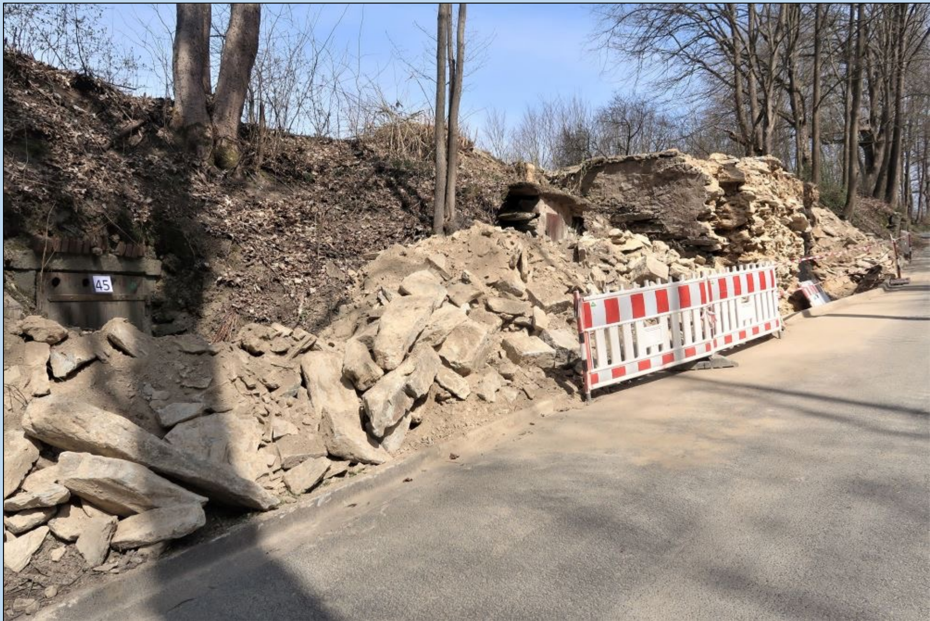
neues aus Nordbayern - Sanierung von 35 Felsenkellern in der Kellergasse Wunsiedel
