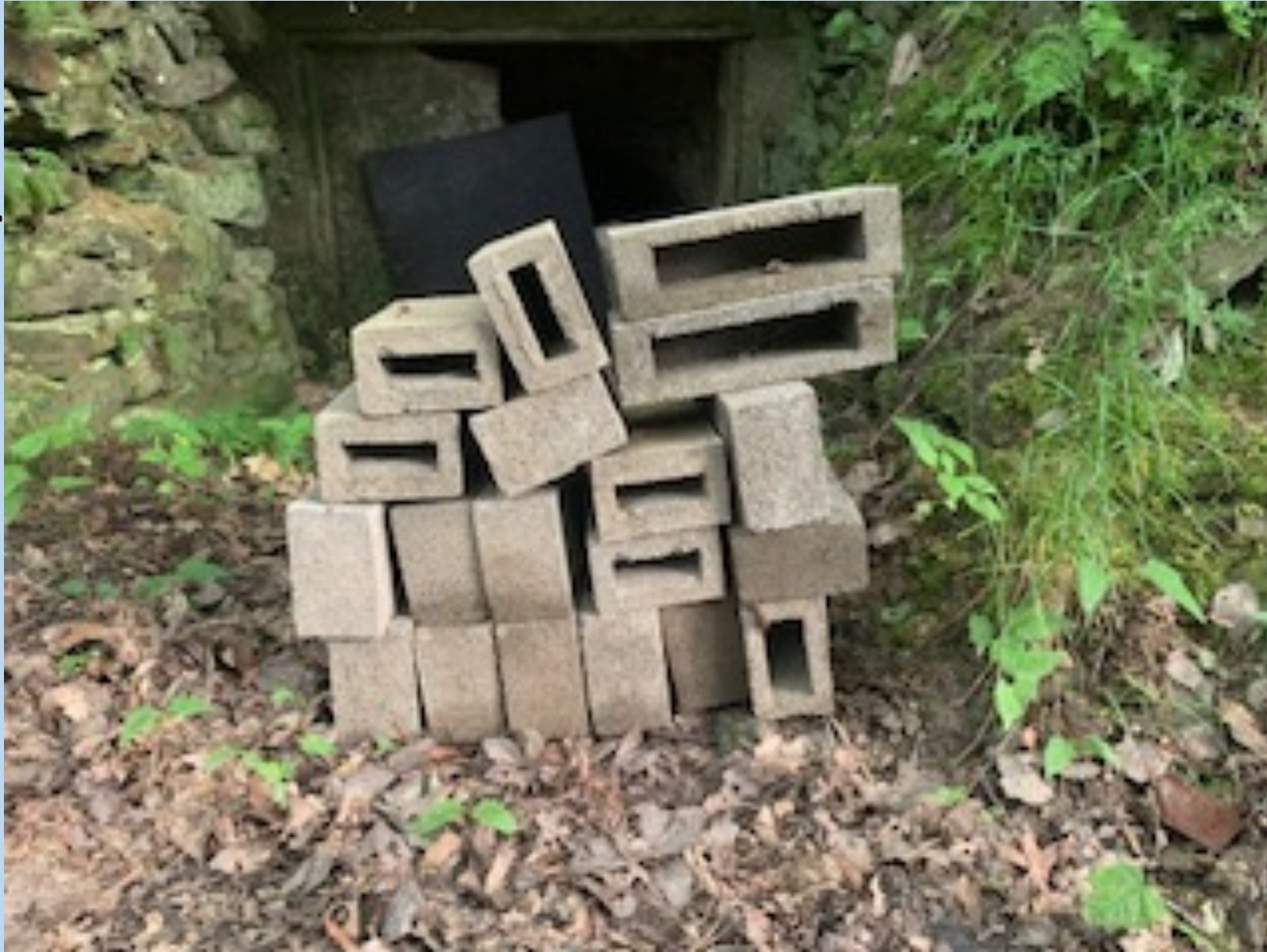
neues aus Nordbayern - Sanierung von 35 Felsenkellern in der Kellergasse Wunsiedel
